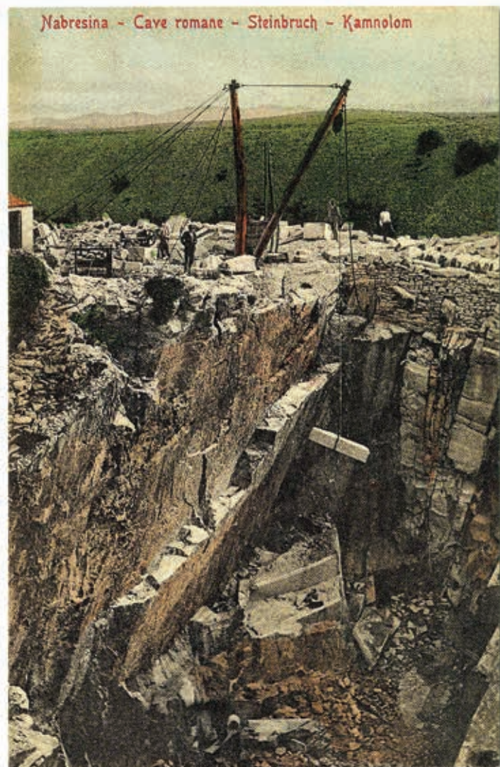
Slika 5.1.3: Fotografija nabrežinskega kamnoloma Cava Romana na stari razglednici, kjer je lepo vidno dvigalo »derrick«
