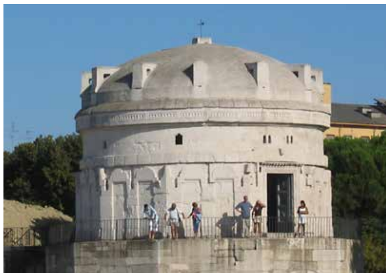
Slika 5.1.4: Teoderikov mavzolej v Raveni s streho, izdelano iz enega bloka Nabrežinskega apnenca (foto: Franco Cucchi)
