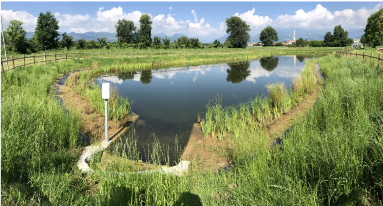
Figura 2: Un bacino di ritenzione in ambito agricolo in località Giavenale di Schio, uno degli interventi del progetto BEWARE.
