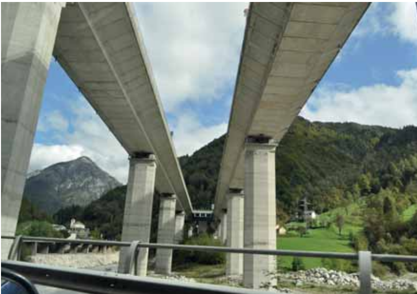
SS 13 km 195 VII. L'impatto dei pesanti piloni in calcestruzzo del viadotto sul paesaggio montano fa riflettere sul consumo di suolo legato alle infrastrutture e sulle possibilità non sufficientemente esplorate di realizzare viadotti con una tecnologia costruttiva meno dirompente sul territorio, tipo ponti ad arco e strutture in acciaio.
