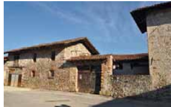
Fig. 5. Insediamento di pianura ben conservato. Si nota la compattezza della cortina esterna e la tessitura muraria in ciottoli; la corte è delimitata in parte da un annesso rustico in parte da un alto muro di cinta su cui si apre l'ampio portone d'accesso. Foto di Laura Di Bidino.
