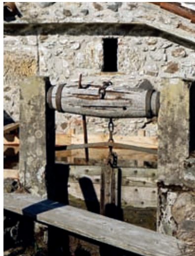
Particolare della puartele o saracinesca che permette lo svuotamento del vagn o poç naturâl .
