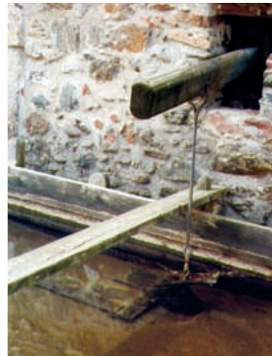
Una caditoia posta nel fondo del vagn ed il suo particolare sistema di apertura dall'interno della Farie .
