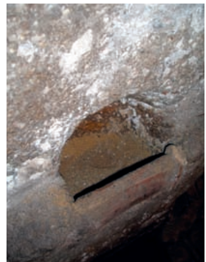
La nicje che accoglie il saldan : sabbia silicea che aveva la capacità di staccare dal ferro le scorie.
