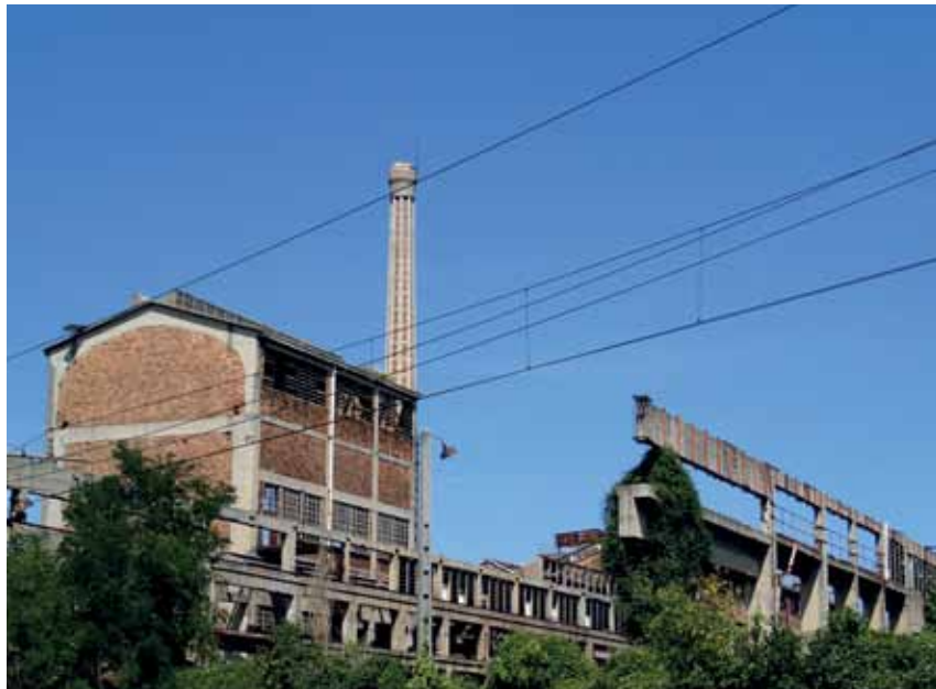
Il complesso delle acciaierie S.A.F.A.U. nella zona sud della città di Udine; è evidente lo stato di abbandono e degrado.
