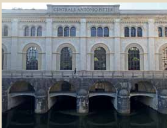
La centrale idroelettrica "Antonio Pitter" a Malnisio di Montereale Valcellina. Edificata a partire dai primi mesi dell'anno 1900 e chiusa nel 1988, è ora sede di museo ed esempio di archeologia industriale. Ospita un interessante Immaginario Scientifico con percorsi interattivi.
