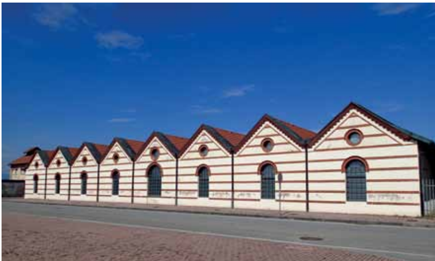
Padiglioni dell'ex Cotonificio Cormôr: le finestre, nella posizione originale, assicuravano molta luce all'interno, nella zona di lavoro. Particolare la copertura detta a "denti di sega".
