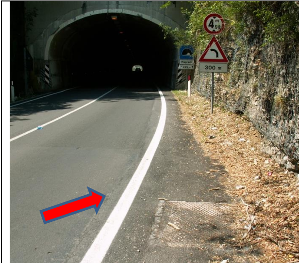
Inizio cantiere in scavo lungo SR 251
